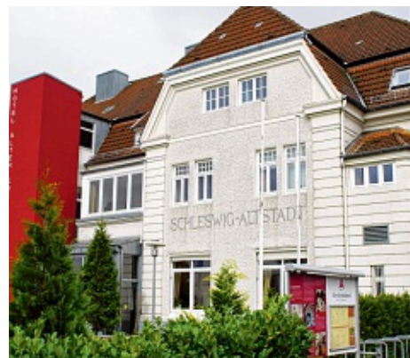
Der Alte Kreisbahnhof ist ein Referenzobjekt der Tischlerei Kluge.
